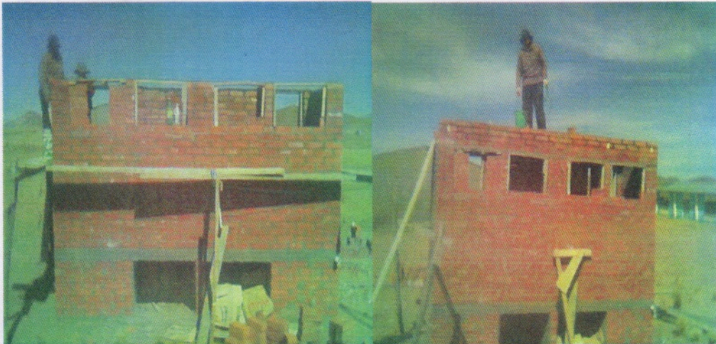
Construcción de dos baños ecológicos con una parte sobrante de dinero de Alcaldía de Torino Italia
