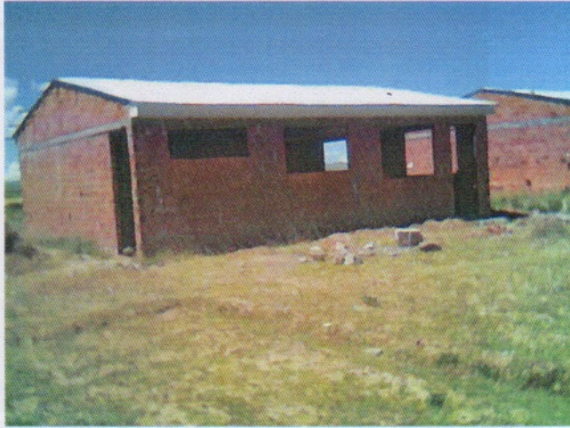
INICIO DE LA OBRA FINA DEL TALLER DE MECANICA INDUSTRIAL NOVIEMBRE 2007
